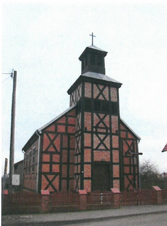
Kościół w Kleszczynie po wykonanych pracach remontowo - konserwatorskich
