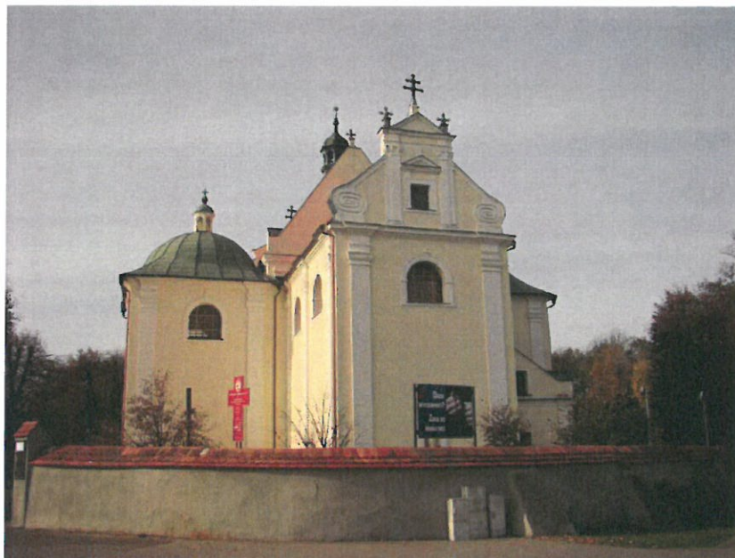
Żłotów, kościół parafialny p.w. Wniebowzięcia NMP, 1660 – 1664 r.
